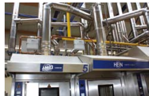
Zwei Zähler ermittelten den genauen Gasverbrauch der beiden Öfen.
